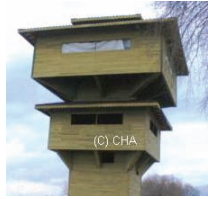
* Kuş Gözlem Kulesi
